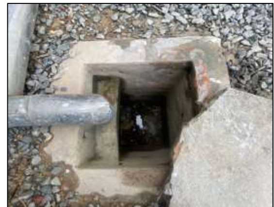
ระบบระบายน้ำฝนจากหลังคาหลังสูบน้ำ
